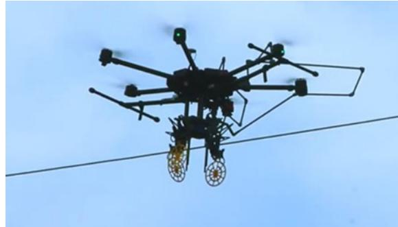
Рис. 5. Установка ПЗУ-М-4 на провод ВЛ с БПЛА.
