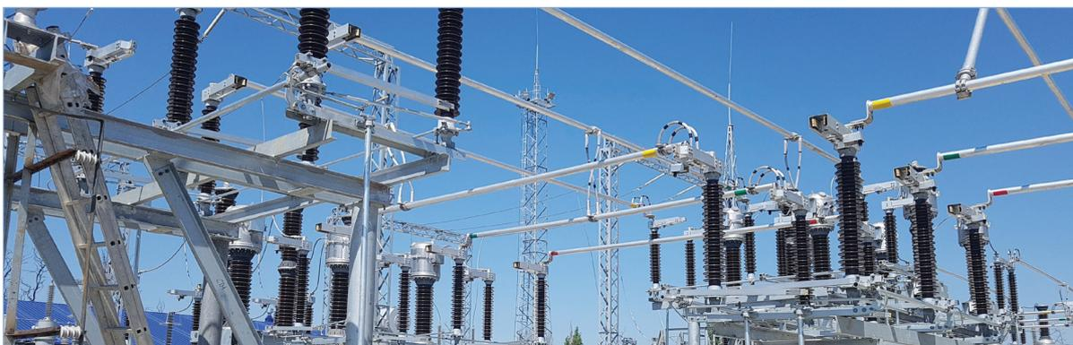
Ошиновка Жесткая производства ПЛП РУС – предназначена для выполнения многопролетных сборных шин и электрических соединений между высоковольтными аппаратами в распределительных устройствах.
