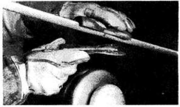
2. Установите по отвесу блок с гирляндой изоляторов и пометьте провод по центру катушки. Используя маркер или цветной карандаш, не царапайте провод, это может привести к изнашиванию провода. Расположите провод за концами стержней, чтобы почистить изолятор и блок с гирляндой изоляторов.
