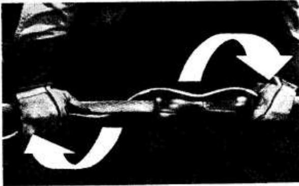
5. Накрутите стержень на провод, сделав по два витка с каждой стороны вставок, для того, чтобы зафиксировать стержень на месте и предотвратить случайное раскручивание.
